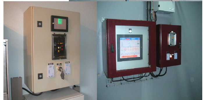
Coffrets de découplage: différentes présentations
